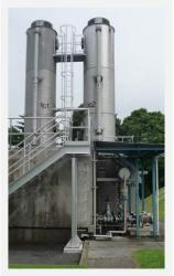
そのため、飲料水製造施設では、エアーストリッピング法(揮発法)を用いた処理装置で井戸水のTCE濃度を下げています。エアーストリッピング法(揮発法)とは、清浄な空気と揮発性の有機物に汚染された水とを蒸気状態で反応させることでその有機物を気体にして水から分離する方法です。この処理方法で約70~100%のTCEを除去できます。このTCE 除去装置で、TCE濃度15 ppb(微少含有比率;10億分の1)の水を最大許容汚染物濃度5ppb(JEGS第
